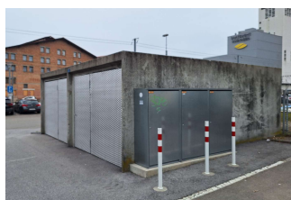
Garage neben dem Bahnhofbuffet
